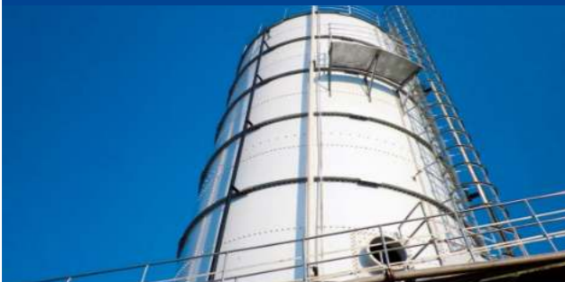
IC（内循环厌氧反应器）
